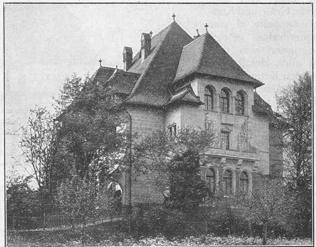
Abb. 2. Ansicht der Villa Sonnenberg von Norden.
